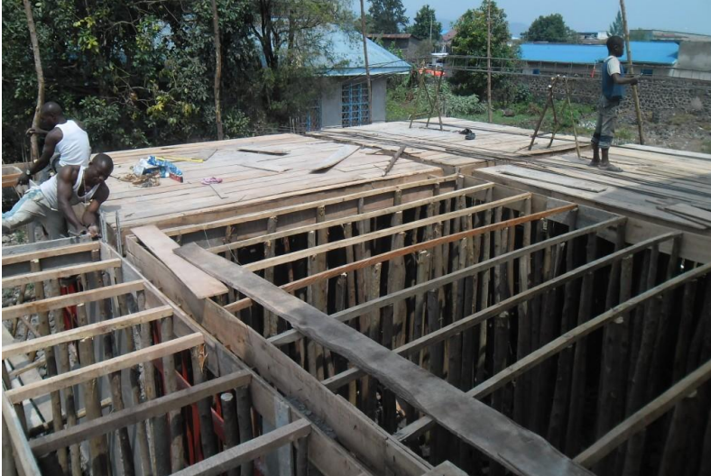
Die Deckenschalung wird eingebracht.
