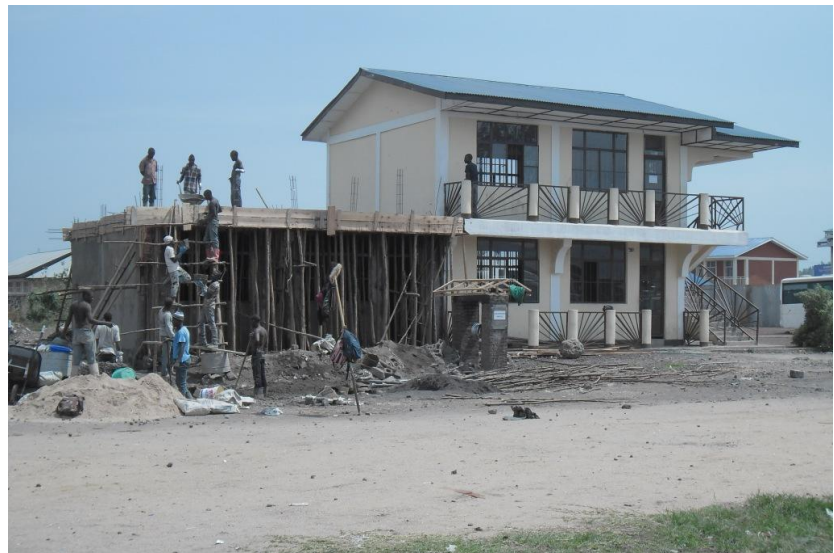
Die Decke wird ohne Kran und Beton-Mischmaschine betoniert.
