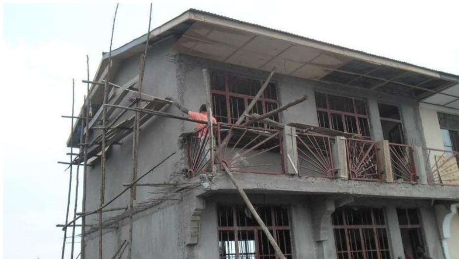
Der Rohbau ist fertig.
