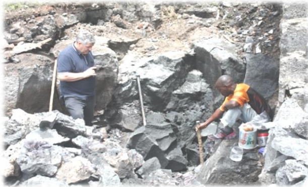
Vorbereiten des Fundaments im Febr. 2009
